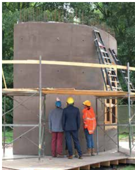
Proefstort van een schoonbetonwand voor het Waterliniemuseum. De mix van donkere kleurstoffen is niet standaard voor schoon beton. Architect: Anne Holtrop; opdrachtgever: Provincie Utrecht. Foto's op deze pagina: Henk Oude Kempers.
