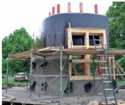
Proefstort van een schoonbetonwand voor het Waterliniemuseum. De mix van donkere kleurstoffen is niet standaard voor schoon beton. Architect: Anne Holtrop; opdrachtgever: Provincie Utrecht. Foto's op deze pagina: Henk Oude Kempers.
